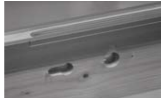
Afb. 16 Uitgefreesd krukgat en cilindergat
